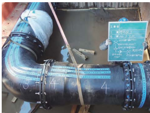
配水管(耐震管)の布設状況
