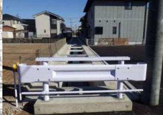
A1-5-2 切通排水路
