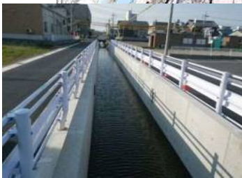
A1-3-2 市橋第6排水路
