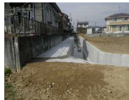
A1-4-1 溝口排水路
