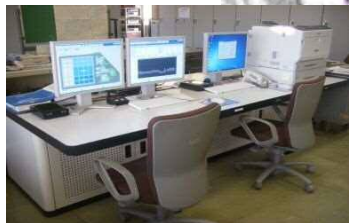
A1-3-6 南部プラント監視装置改築
