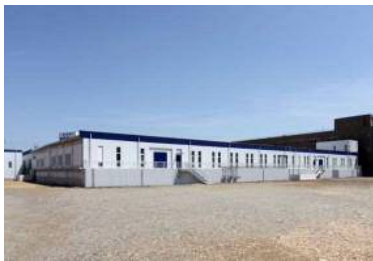
A1-1-3 中部プラント水処理棟改築
