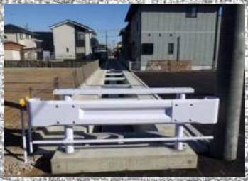
A1-5-2 切通排水路
