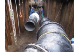
基幹管路の耐震化工事
