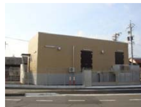
黒野第1加圧施設 (平成27年8月完成)
