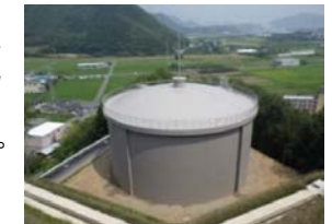
黒野第1配水池(容量4,000m3) (平成26年12月完成)
