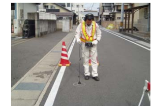
漏水調査の様子
