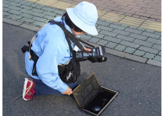
外部委託による水道メーターの検針
