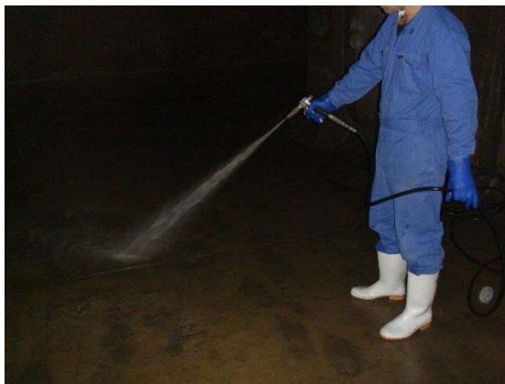
配水池内の清掃作業
