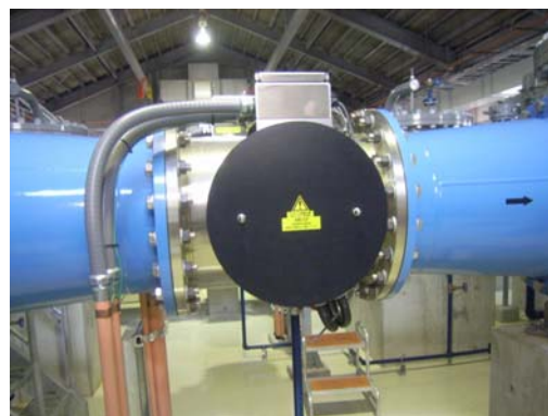
鏡岩水源地 紫外線処理装置
