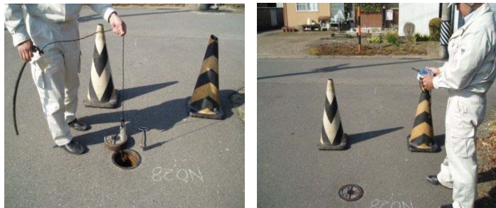
管路音圧監視システム(データロガー)設置の様子
