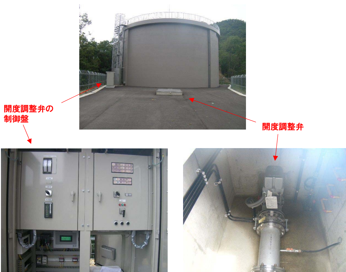
開度調整弁の設置(黒野第1配水池)
