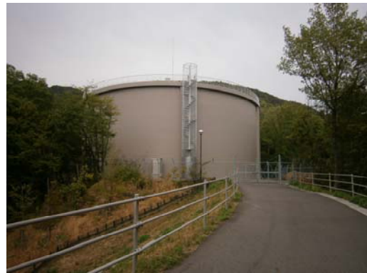
雄総第2配水池(容量 11,300m 3 ) (平成22年3月完成)
