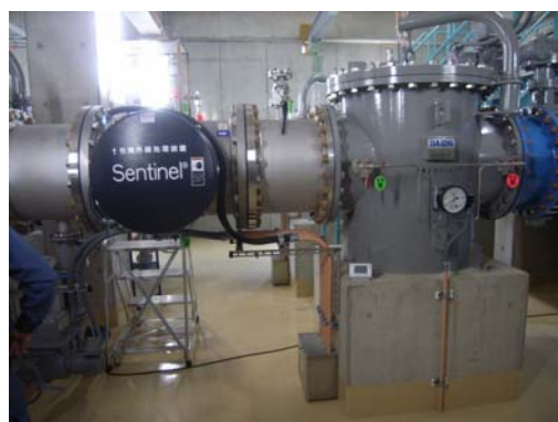
雄総水源地 紫外線処理装置
