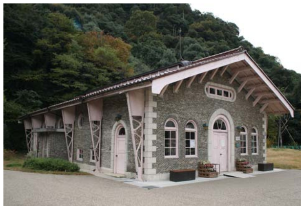
水の資料館(旧エンジン室)
