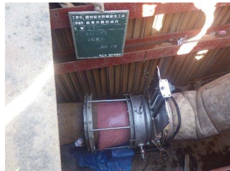
管路更生工法の施工状況
