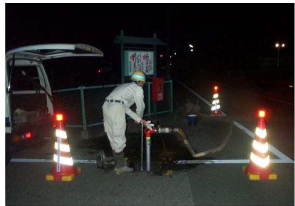
夜間洗管作業(消火栓開栓)
