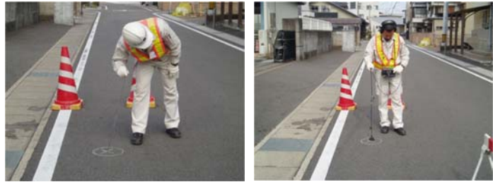
直営漏水調査の様子(左:音聴棒、右:漏水探知機)
