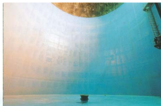
鏡岩配水池(容量 20,000m 3 )の内部
