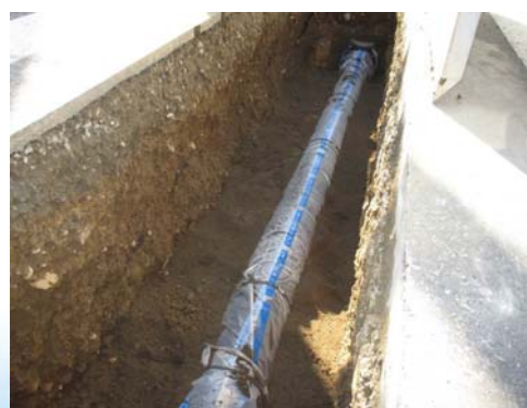
ダクタイル鋳鉄管の布設(ポリエチレンスリーブによる管保護)
