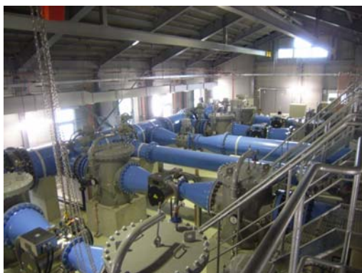
鏡岩水源地 紫外線処理装置
