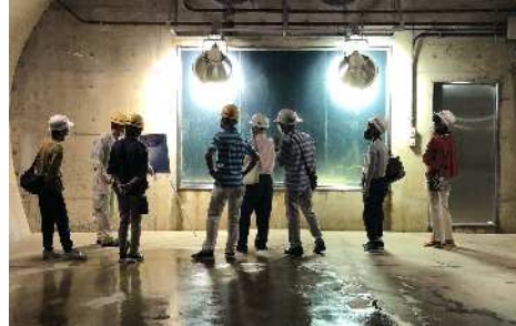
施設見学会の様子（鏡岩配水池）
