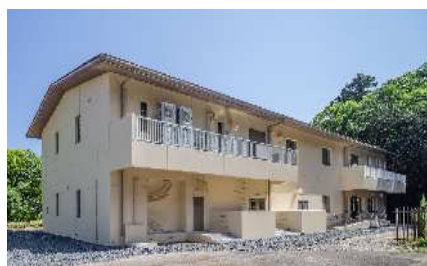
鏡岩水源地管理棟の耐震化
