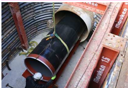
水道管の更新状況（ダウンサイジング）
