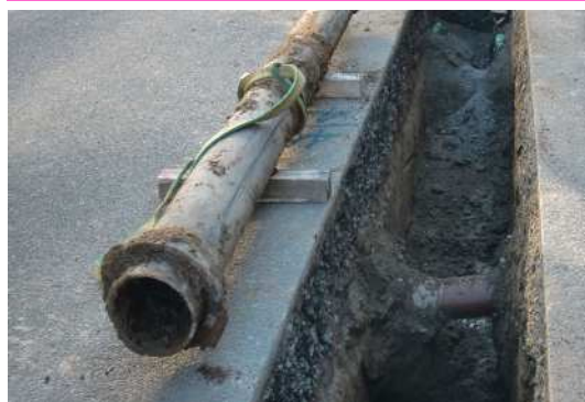
老朽化した水道管の撤去状況
