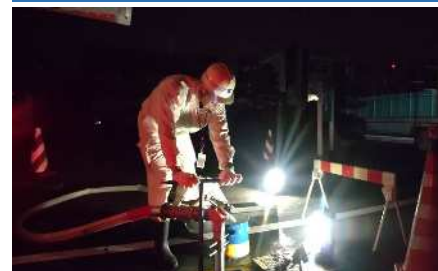
夜間洗管作業（消火栓開栓）
