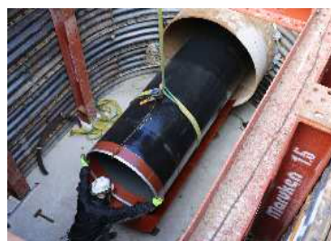
水道管の耐震化
