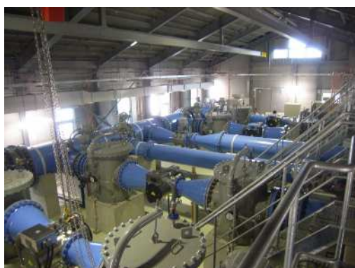
鏡岩水源地 紫外線処理装置
