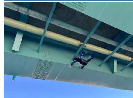
ドローンによる点検状況
