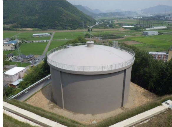
黒野第1配水池(容量 4,000m 3 ) (平成 26 年 12 月完成)
