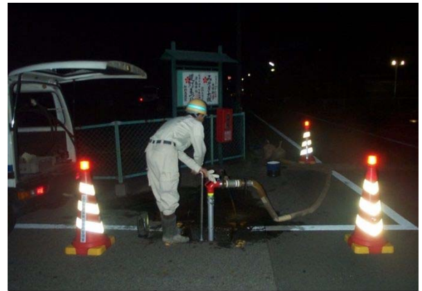
夜間洗管作業(消火栓開栓)
