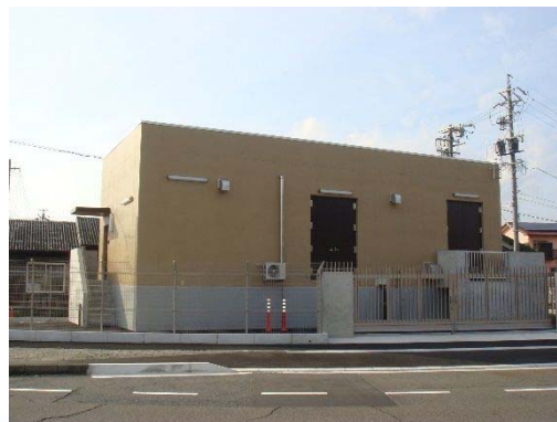
黒野第1加圧施設 (平成27年8月完成)
