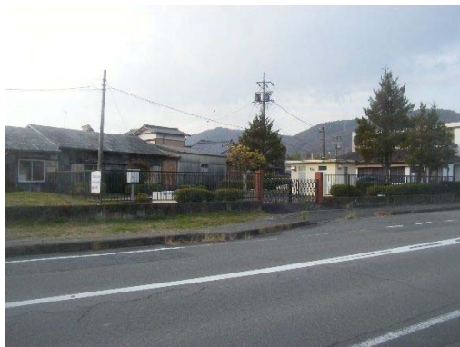
(旧)黒野第1南水源地
