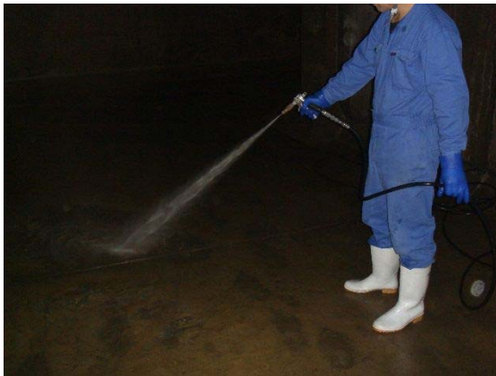
配水池内の清掃作業
