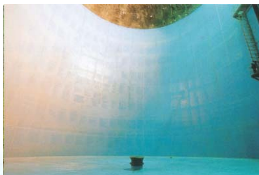
鏡岩配水池(容量 20,000m 3 )の内部
