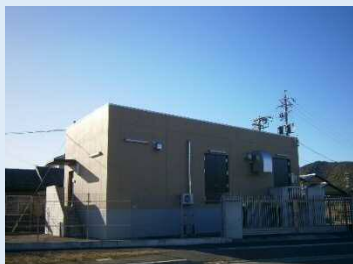
黒野第1加圧施設
