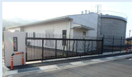
岩野田加圧施設
