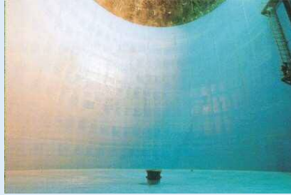
鏡岩配水池（内部）
