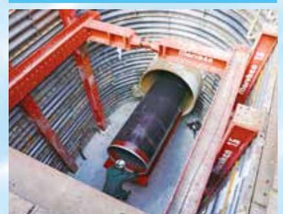
既設管の中に新設する鋼管を挿入する作業のようす
