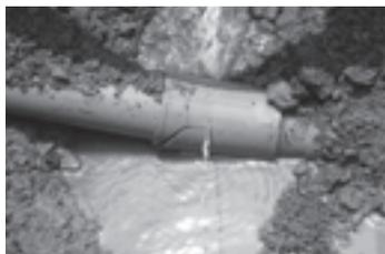
◀水道管の接続部分からの漏水
