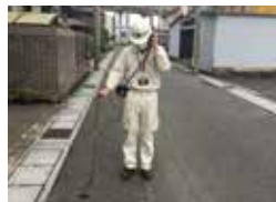
漏水探知機での漏水調査
