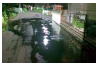
夜間に発生した地上漏水
