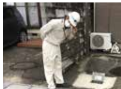
音聴棒での漏水調査
