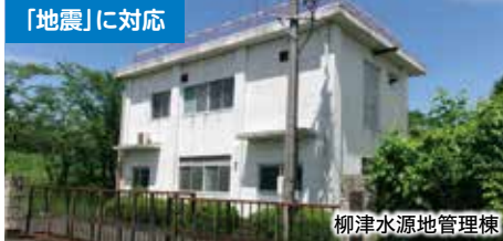
柳津水源管理棟
