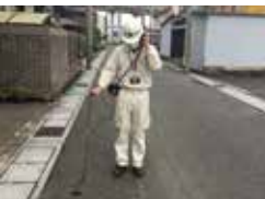
漏水探知機での漏水調査
