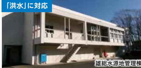
雄総水源管理棟
