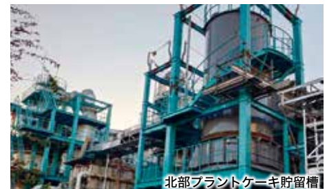
北部プラントケーキ貯留槽
