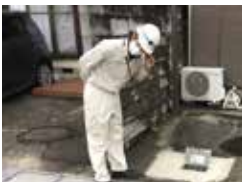
音聴棒での漏水調査
