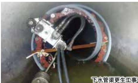
下水管渠更生工事
