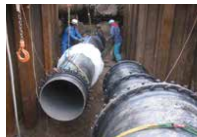
水道管の幹線の耐震化
