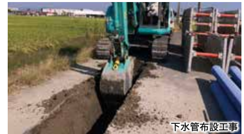
下水道管布設工事
