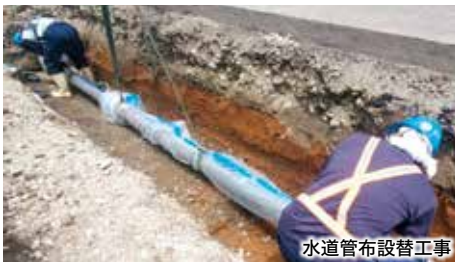
水道管布設工事
