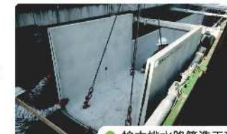
●柏木排水路築造工事
