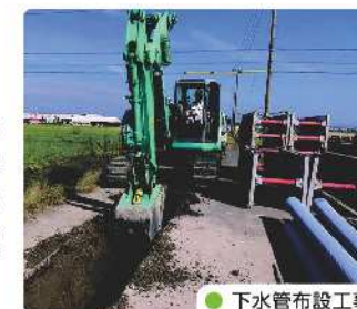
●下水管布設工事
