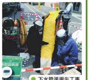
●下水道渠更生工事
