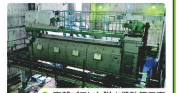
●南部プラント脱水機改築工事
