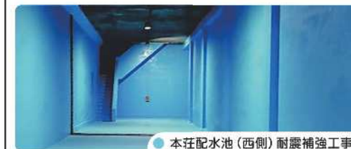
●本荘配水池（西側）耐震補強工事
