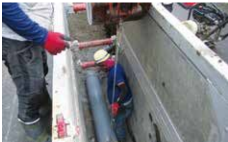
下水道管布設替工事の様子
