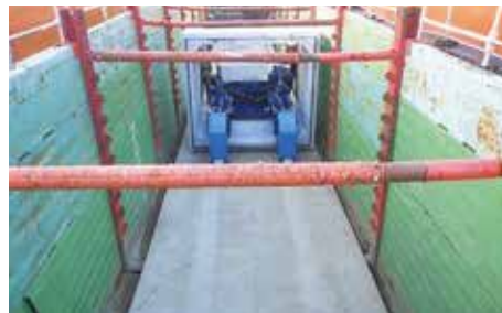
雨水排水路築造工事の様子
