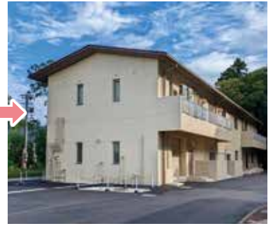
鏡岩水源地新管理棟（令和6年度内完成）
