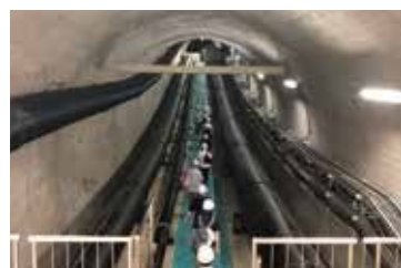
鏡岩配水池入口の様子
