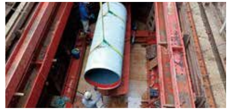
水道管布設替工事の様子
