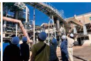
汚泥焼却施設見学の様子
