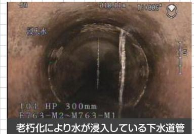
老朽化により水が浸入している下水道管
