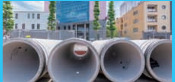
布設前の下水道管
