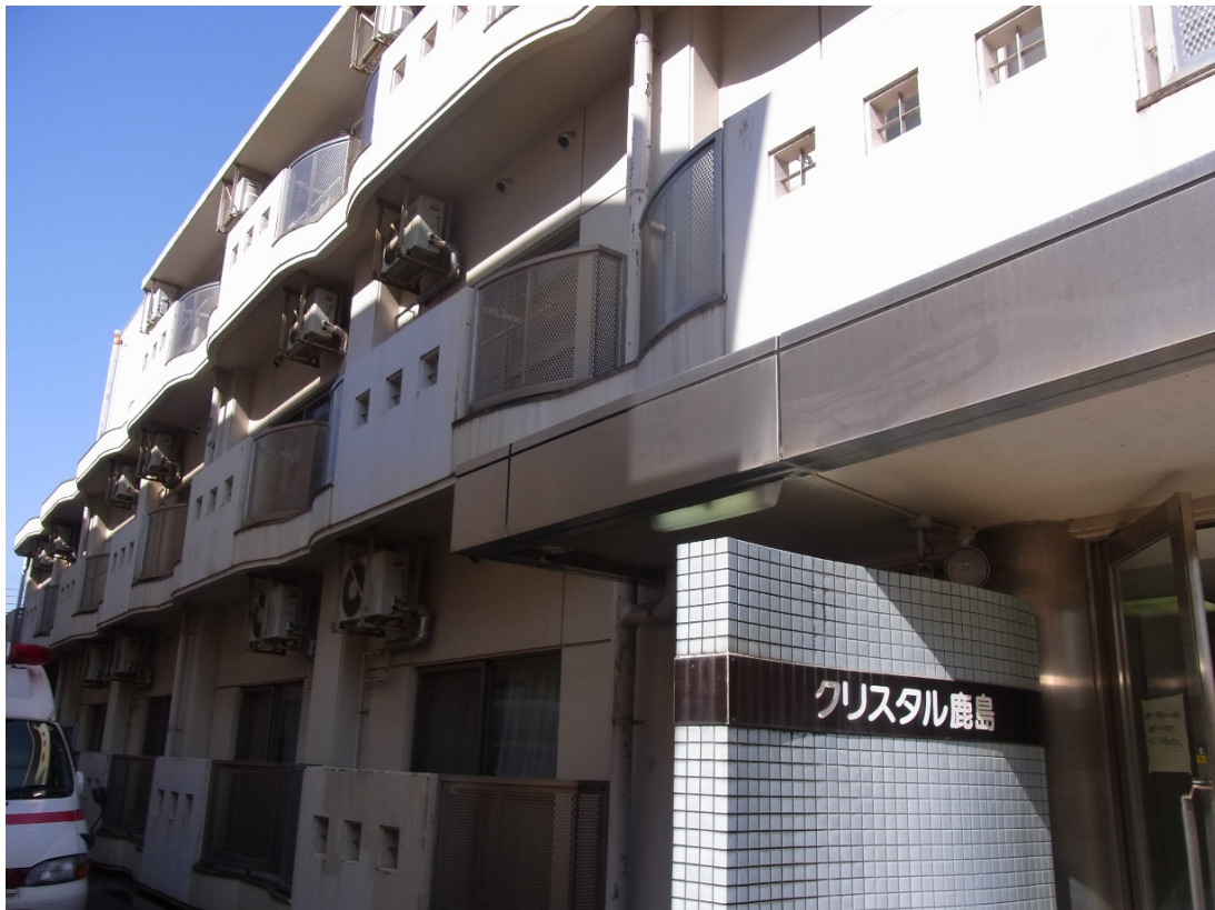
図 2.3 クリスタル鹿島の外観
