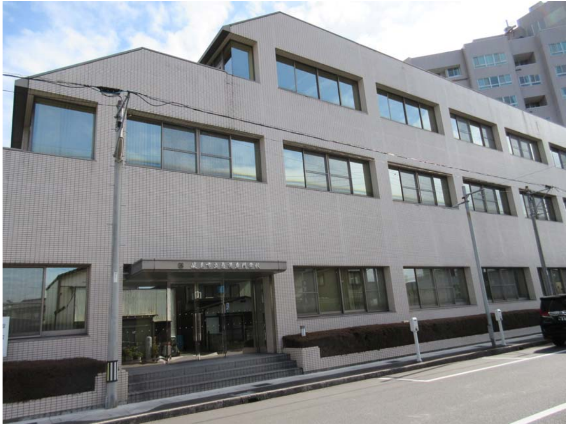
図 2.2 岐阜市立看護専門学校の外観
