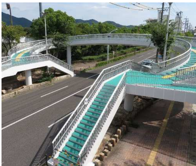
学園町歩道橋（令和 4 年 8 月修繕）
