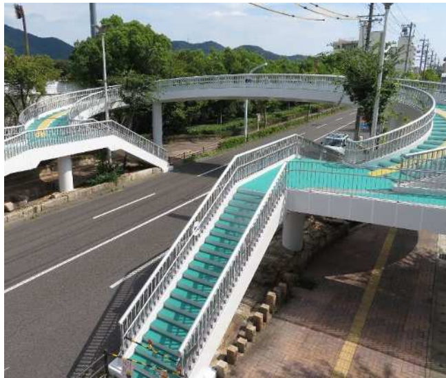
学園町歩道橋（令和 4 年 8 月修繕）
