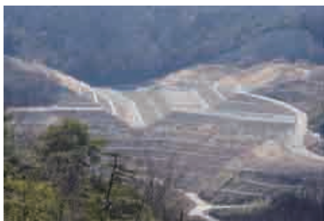
対策工事終了後の現場
