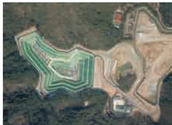
大杉一般廃棄物最終処分場
