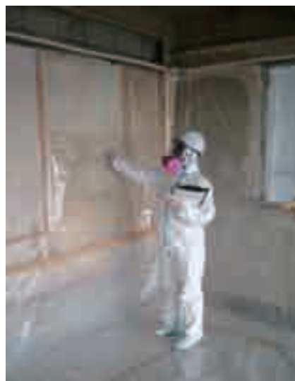
アスベスト除去作業立入検査
