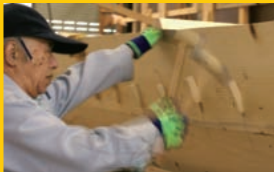
▲クギを打ち込んだ後、防水のために、クギの打ち込み口(ダキ)に埋木を打ち込んでいきます。
