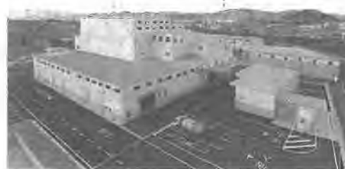
新リサイクルセンター(東から撮影)
