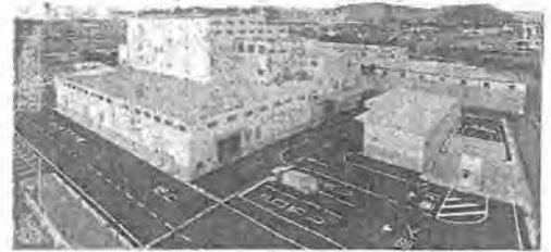
新リサイクルセンター(東から撮影)
