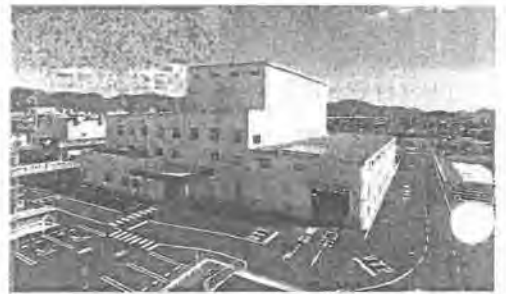
新リサイクルセンター(西から撮影)
