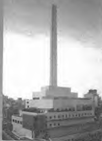
渋谷清掃工場 Shibuya Incineration Plant
