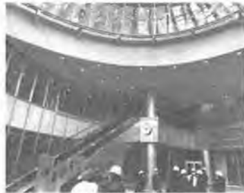
南側玄関入口
