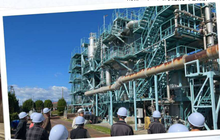
北部プラント(下水処理場)
