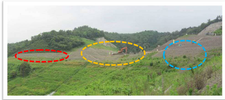
平成24年6月現場内より
