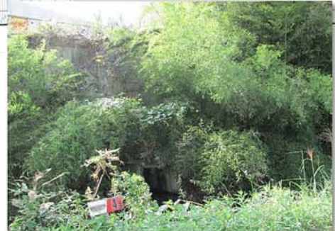
D-2 (排水) 状況写真 ①
