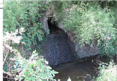
D-2 (排水) 状況写真 ②
