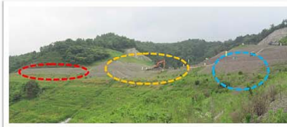
平成24年6月現場内より
