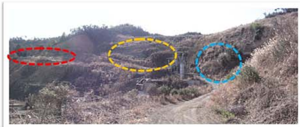
平成20年1月現場内より
