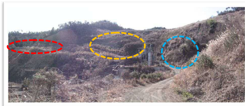
平成20年1月現場内より
