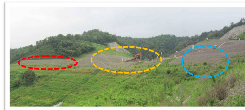
平成24年6月現場内より
