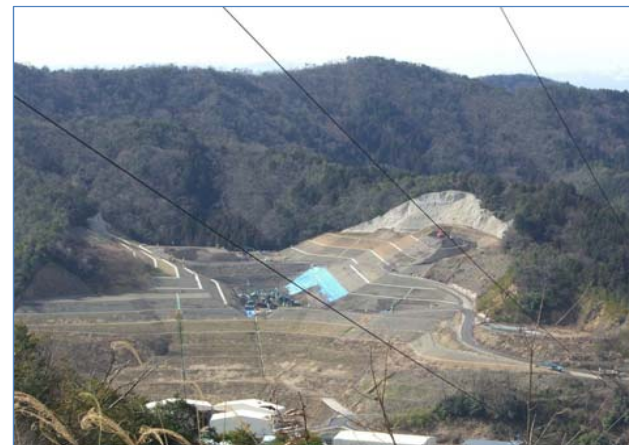
平成24年2月現場北側より
