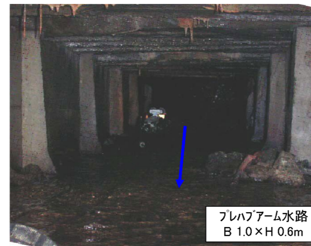
⑧ 下流部排水路状況 H16.6撮影
