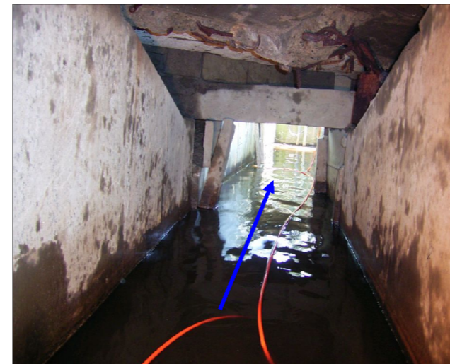
⑨ 下流部排水路状況 H16.6撮影
