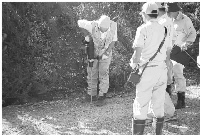
写真3 ハンマードリルを用いた開孔状況
