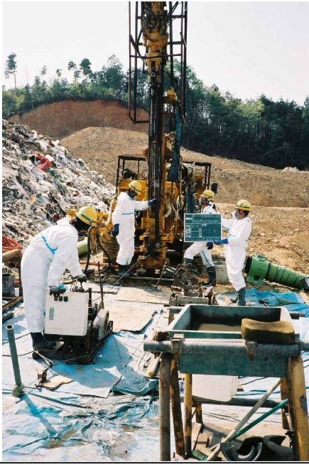
ボーリング調査の状況
