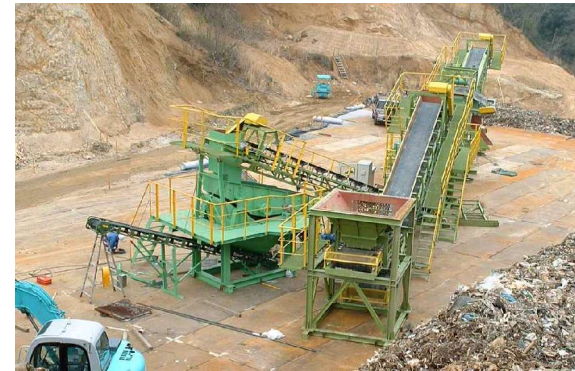
焼却炉無害化区画養生
