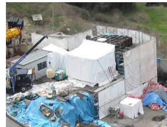
仮置き場遮水シート設置状況
