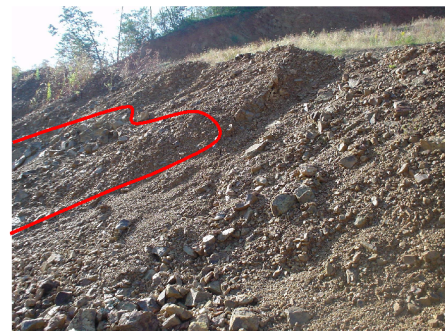
砂岩露出（割目多い）
