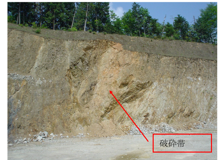
図 1.3.8 切土斜面の断層部分の状況
