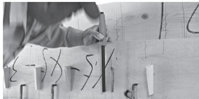
檜材に船釘を打ち込み船底を造る。船釘にはぼうず釘、平釘、傘釘の3種類があり、用途に合わせて使い分け、板をつなぎ合わせる。
