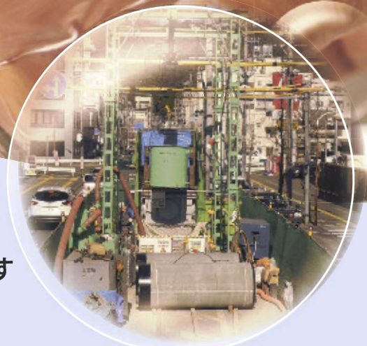
下水道幹線の耐震化工事
