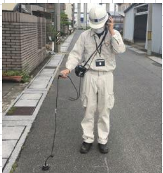
漏水探知機での漏水調査
