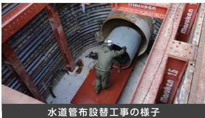
水道管布設替工事の様子
