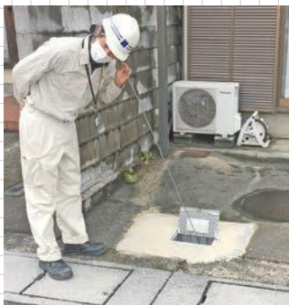
音聴棒 (おんちようぼう) での漏水調査
